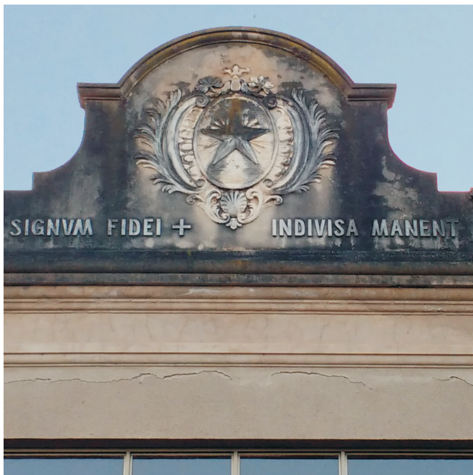
El lema preside la fachada del antiguo noviciado en Córdoba..
