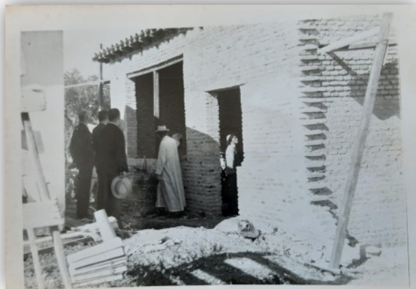
El H. Damián junto a los Hermanos Alberto Weber y Francisco Alberto recorriendo la construcción de lo que sería la escuela de Fátima.
